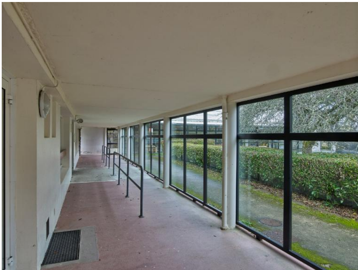
Galerie entre réfectoires et patio. Jean Lacaille, architecte, vers 1966. Galerie vitrée ultérieurement, servant aujourd'hui à abriter la file d'attente du self.
