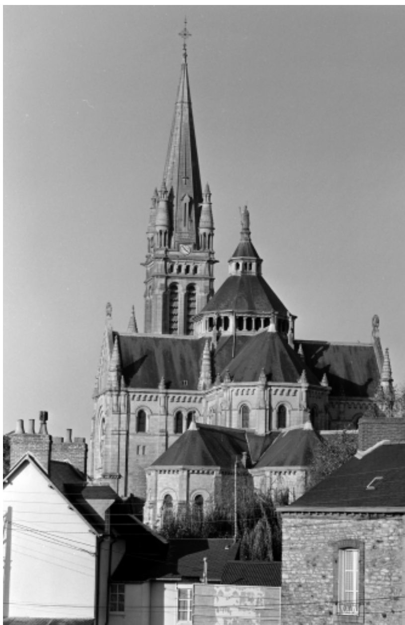
Elévation Est : vue générale.
