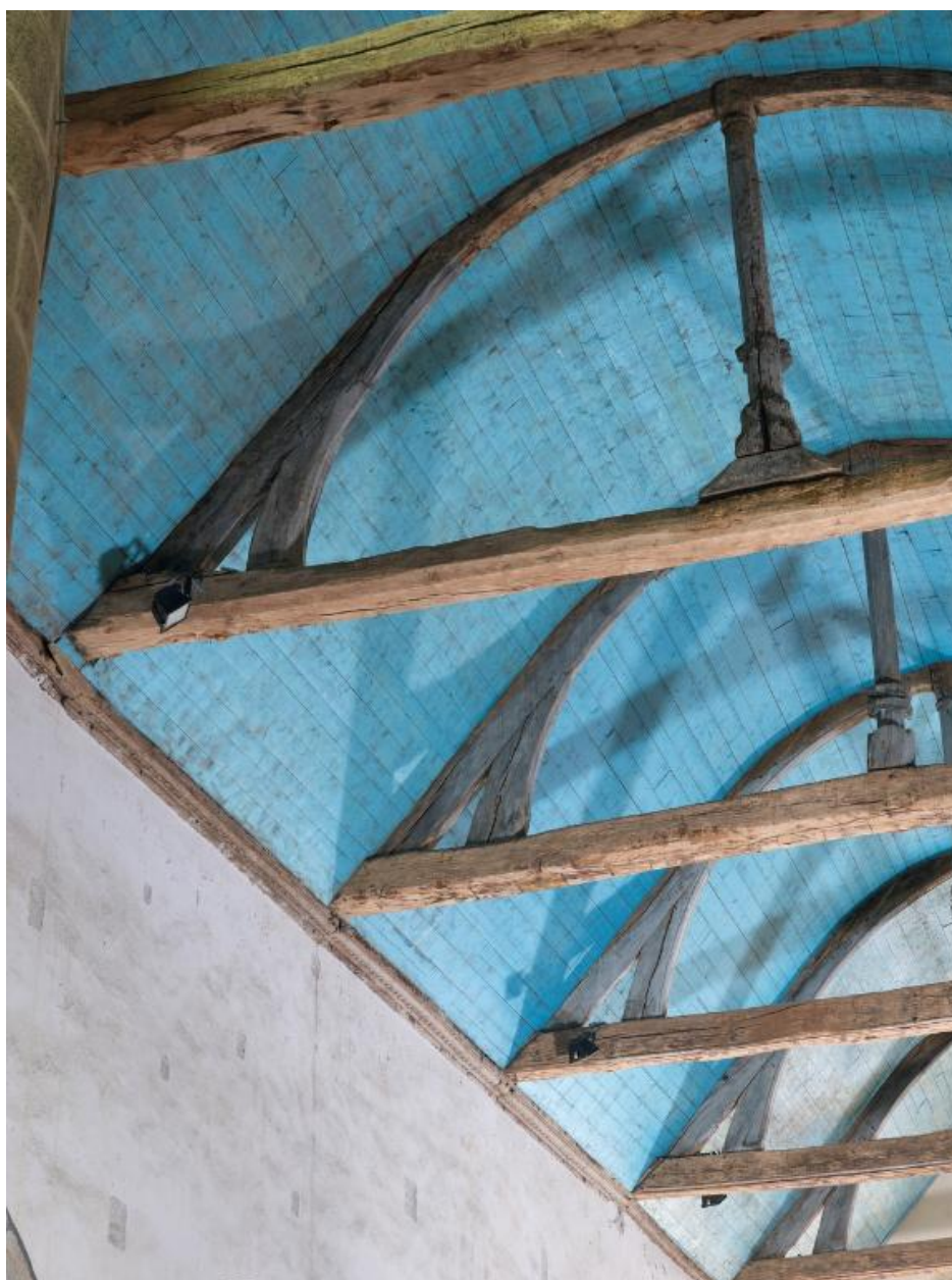
Charpente peinte de la nef vue oblique
