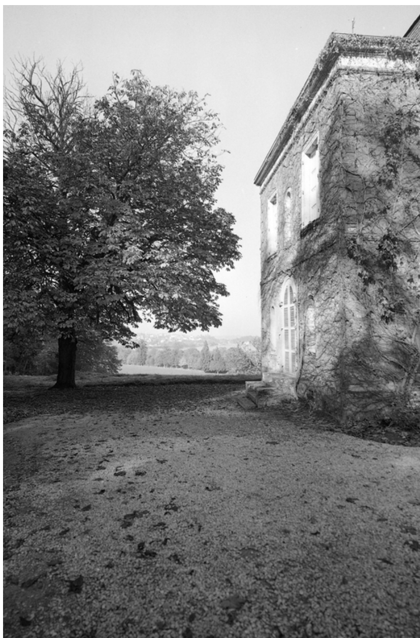
Façade ouest, vue générale.
