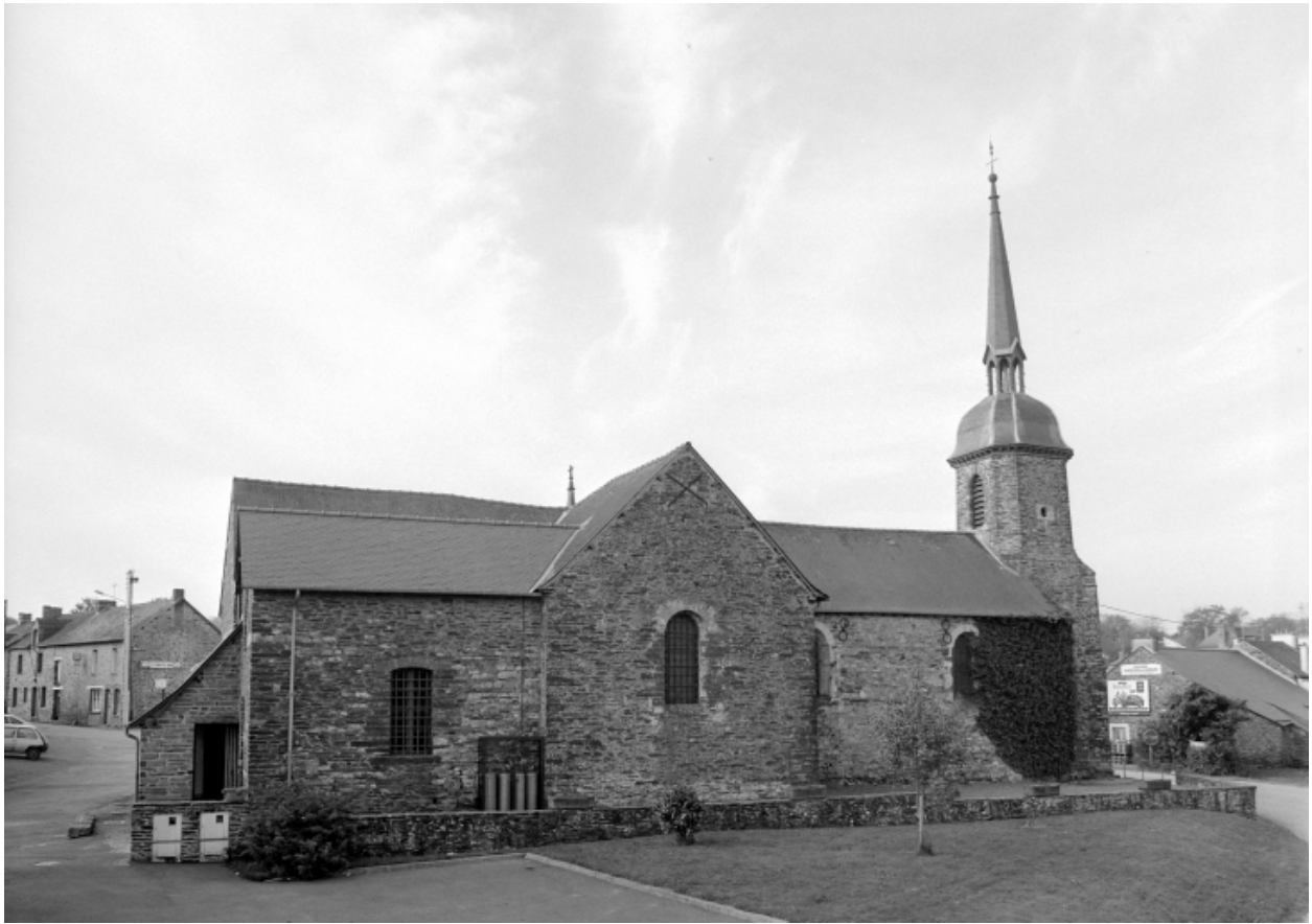
Elévation Nord : vue générale
