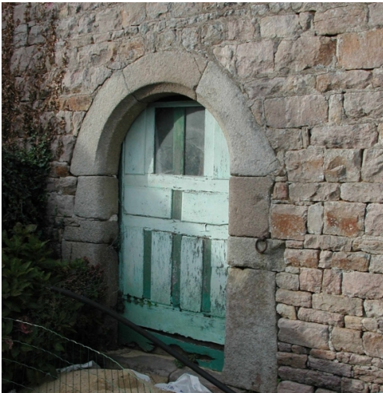
Porte de la façade antérieure.
