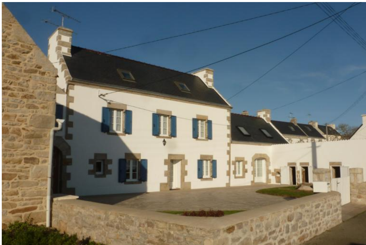
Ferme 4, élévation antérieure de l'alignement principal.
