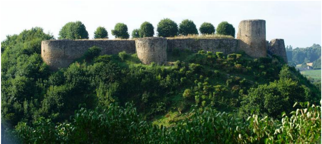
Vue générale nord du château fort (tour nord-est, tour nord et tour nord-ouest)
