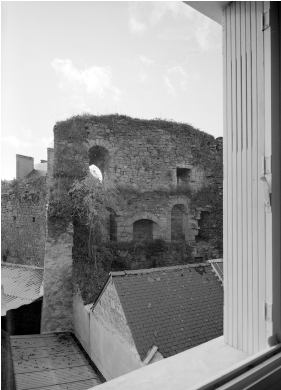
Vue prise du deuxième étage d'une maison voisine, intérieur du logis
