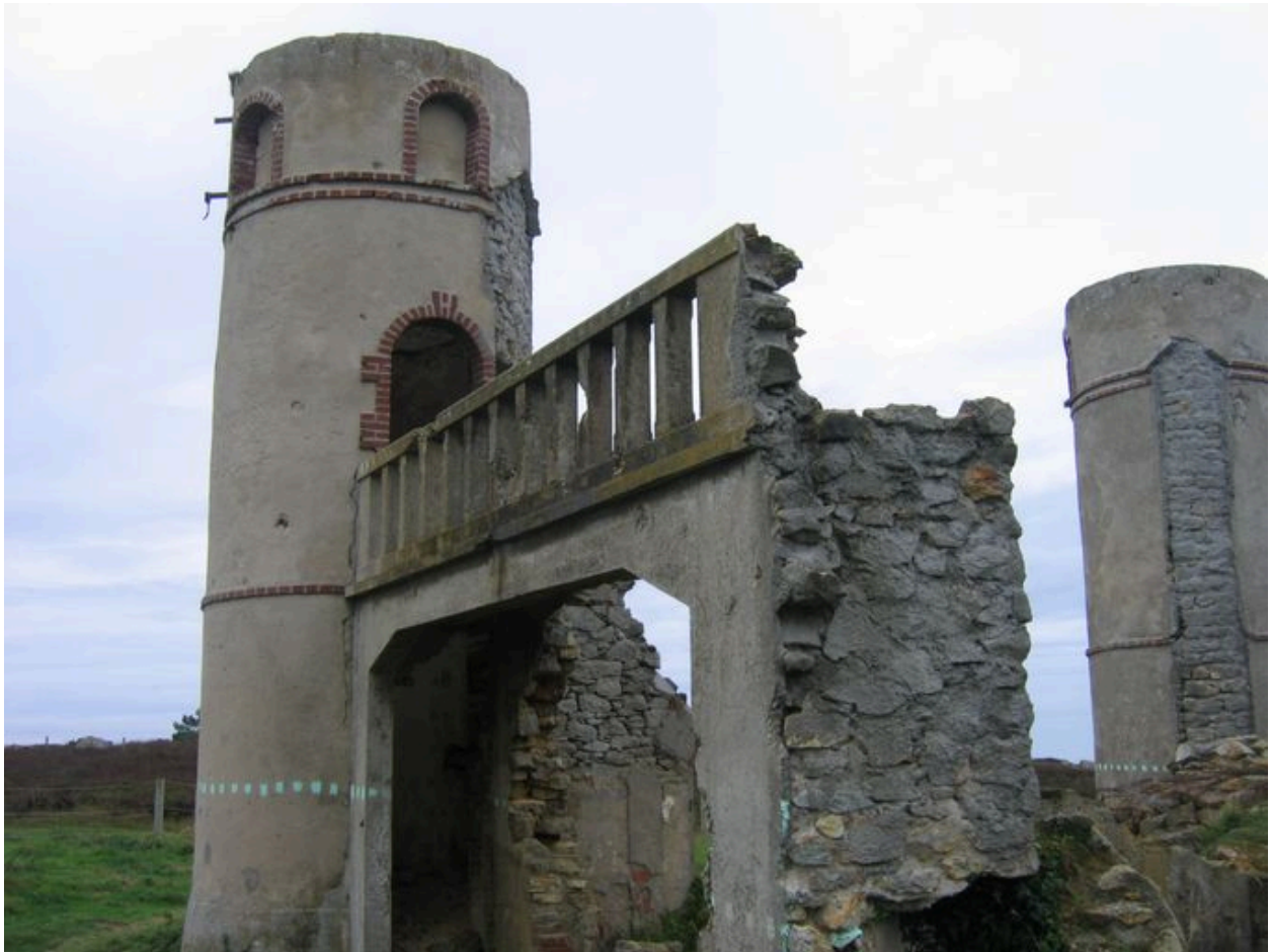
Détail des ruines du manoir de Boul tous : ancienne façade est
