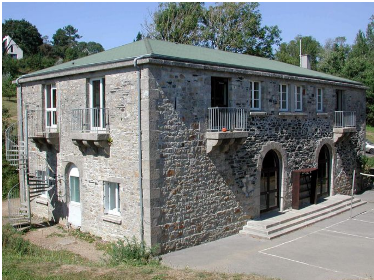
Vue du réduit de batterie de côte de Postolonnec aujourd'hui transformé en centre de colonies de vacances
