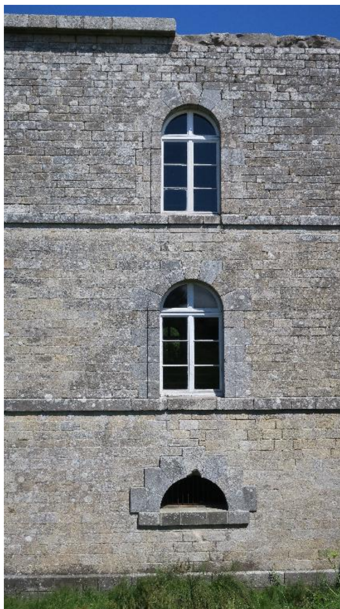
Hoedic, fort central, caserne à l'épreuve, détail de la façade ouest.
