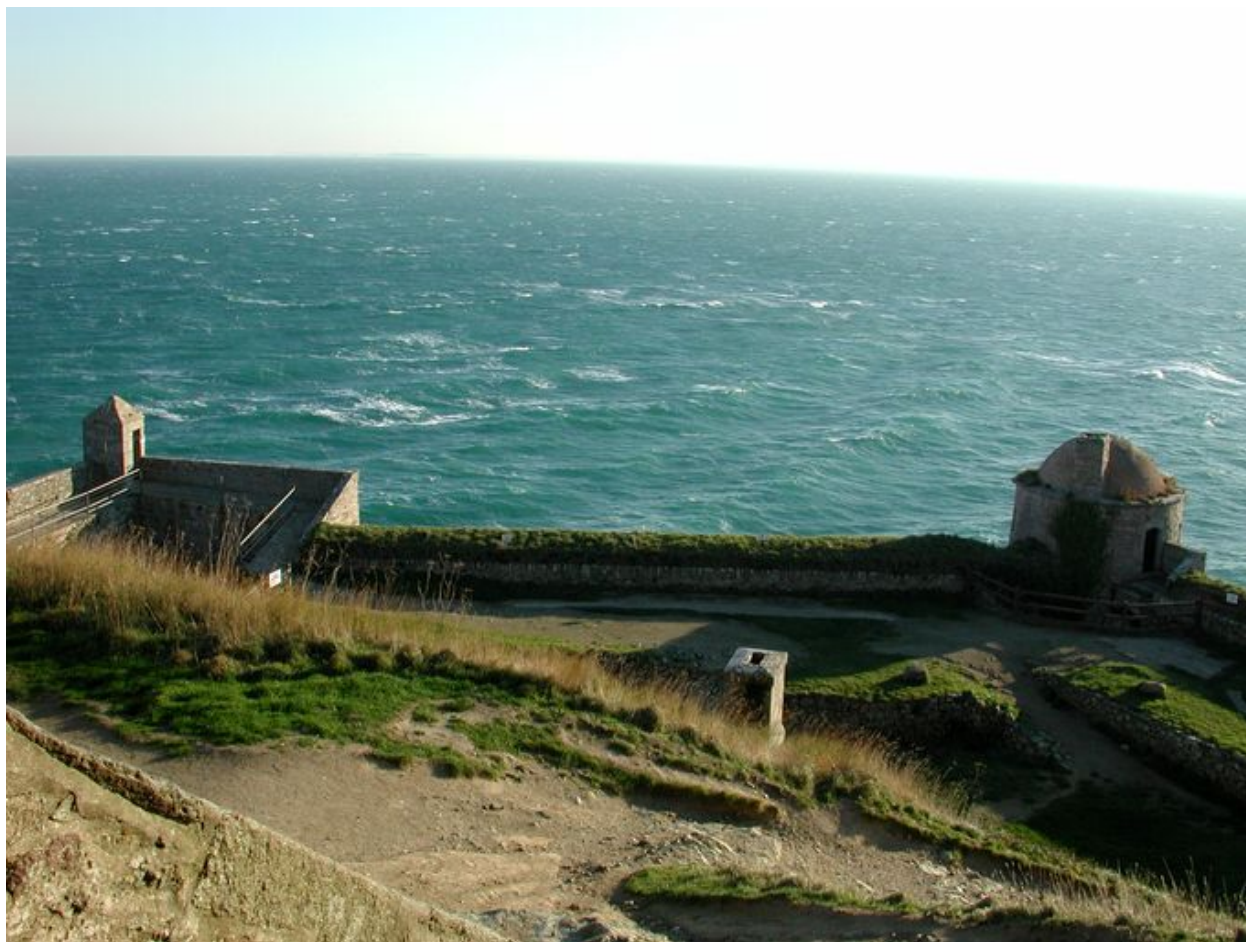
Vue du Fort La Latte
