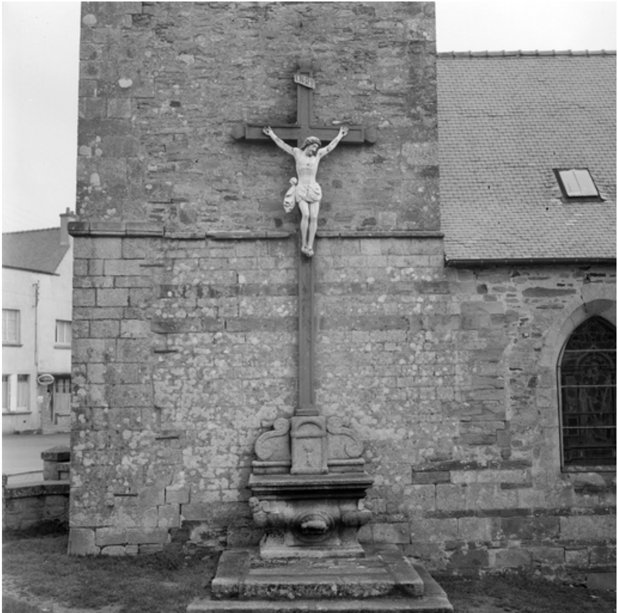
Vue d'ensemble de l'autel et Christ en croix contre la face sud de la tour du clocher
