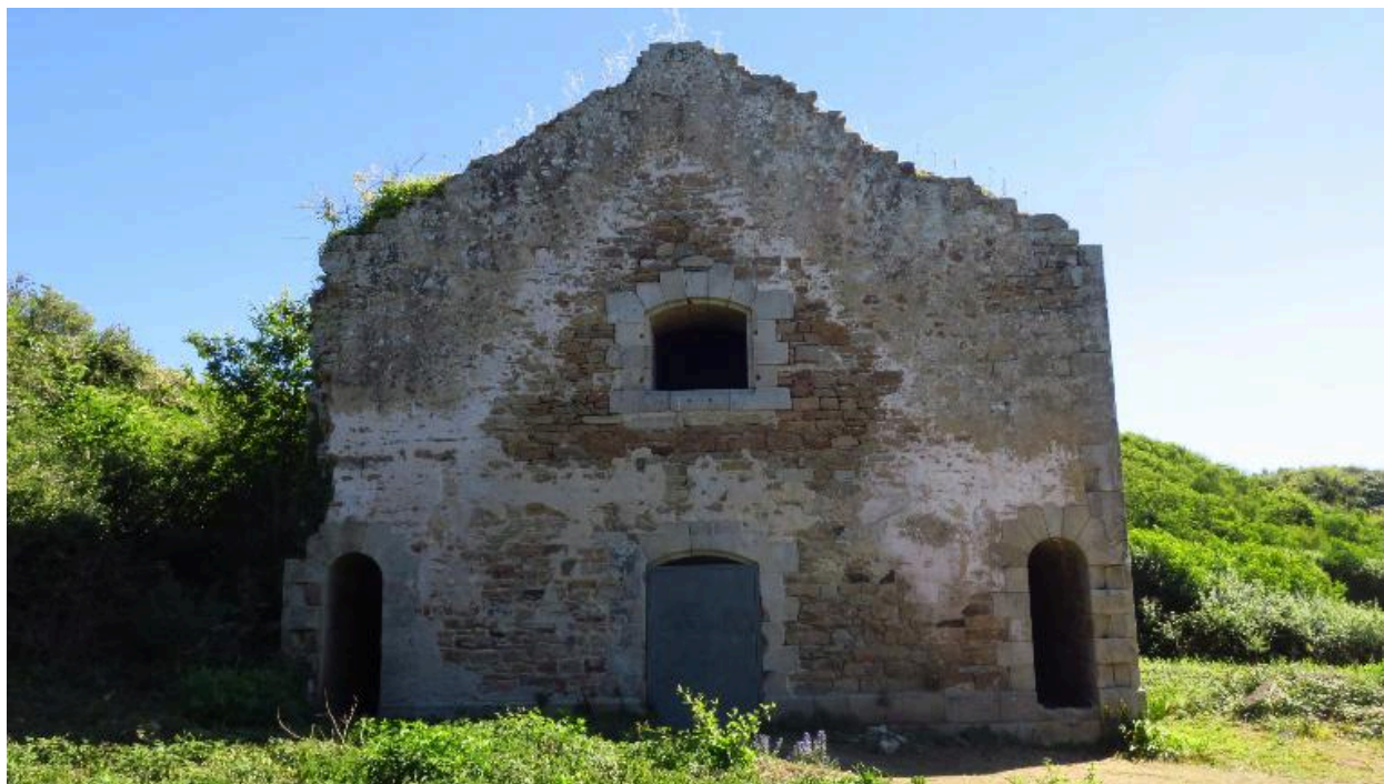
Fort central, Île-d'Houat. Magasin à poudre, façade nord
