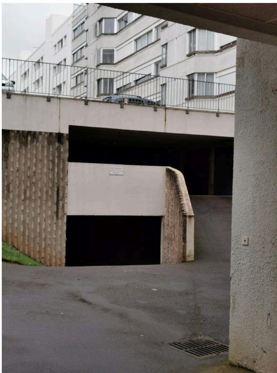
Vue de l'intérieur du coeur d'îlot avec les stationnements aériens et souterrains
