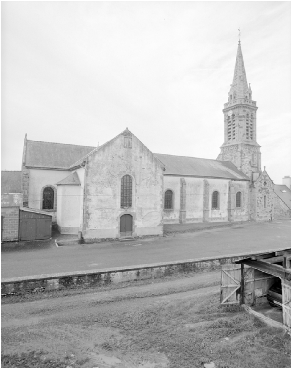
Vue générale nord
