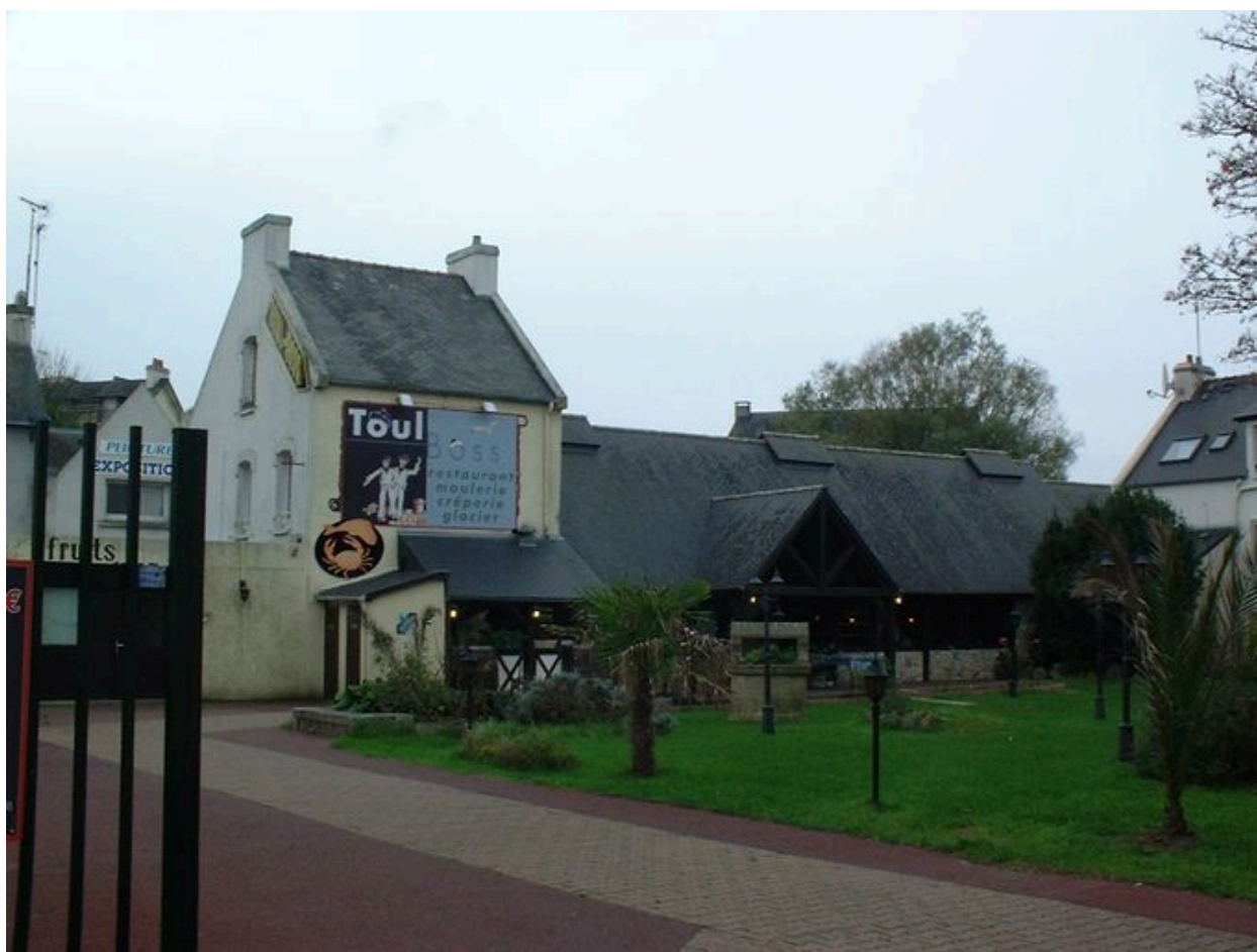
Vue générale avant de l'ancienne conserverie
