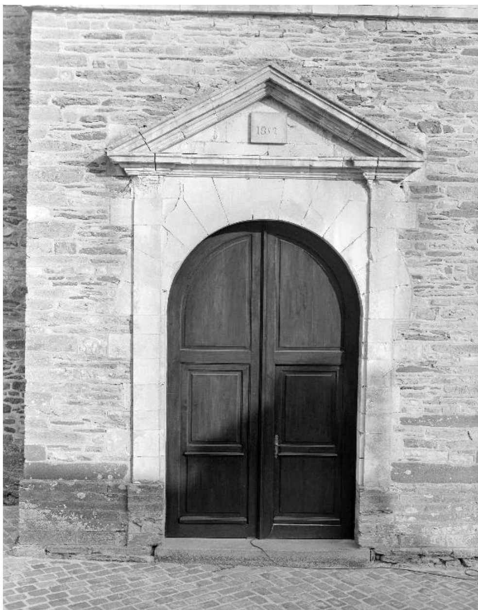
Elévation Ouest, porte : vue générale (Etat en 1994)
