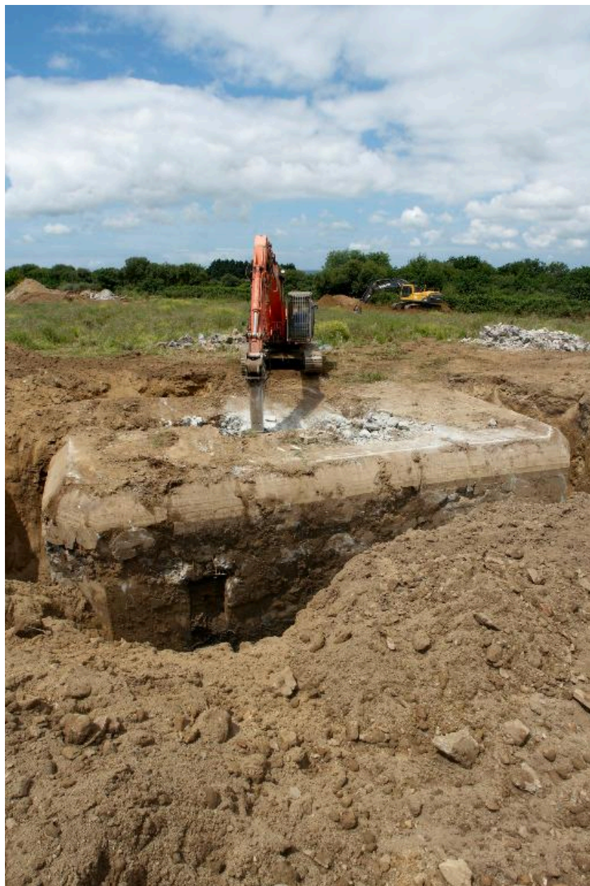
Déconstruction d'un bunker de type 502
