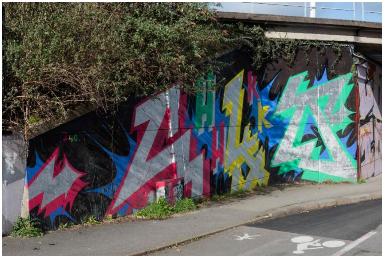
Vue de détail des peintures murales de la culée ouest.
