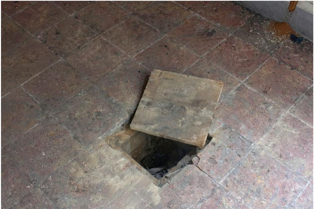
Vue intérieure : détail du système d'évacuation des eaux, puisard (état en 2009)
