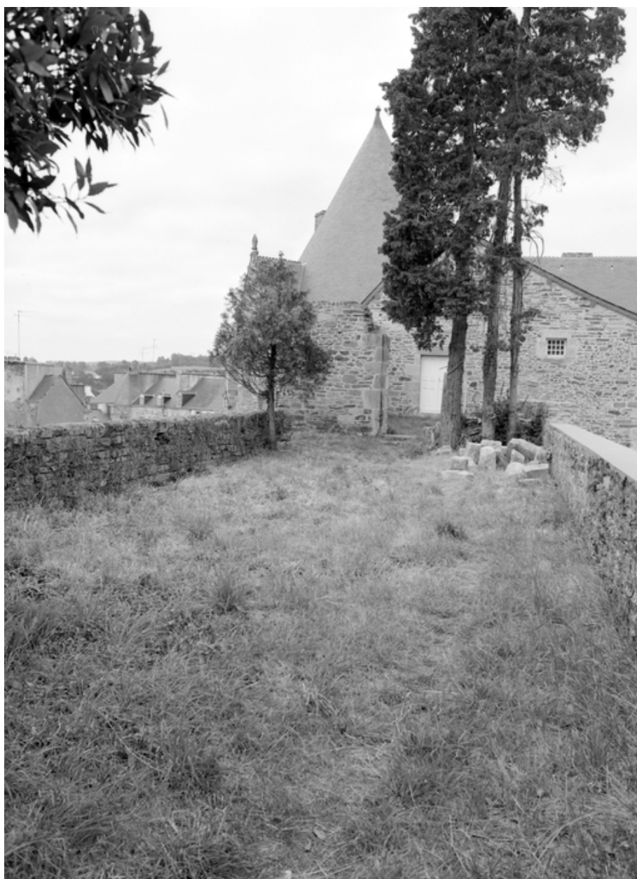
Courtine sud, vue prise vers l'ouest.
