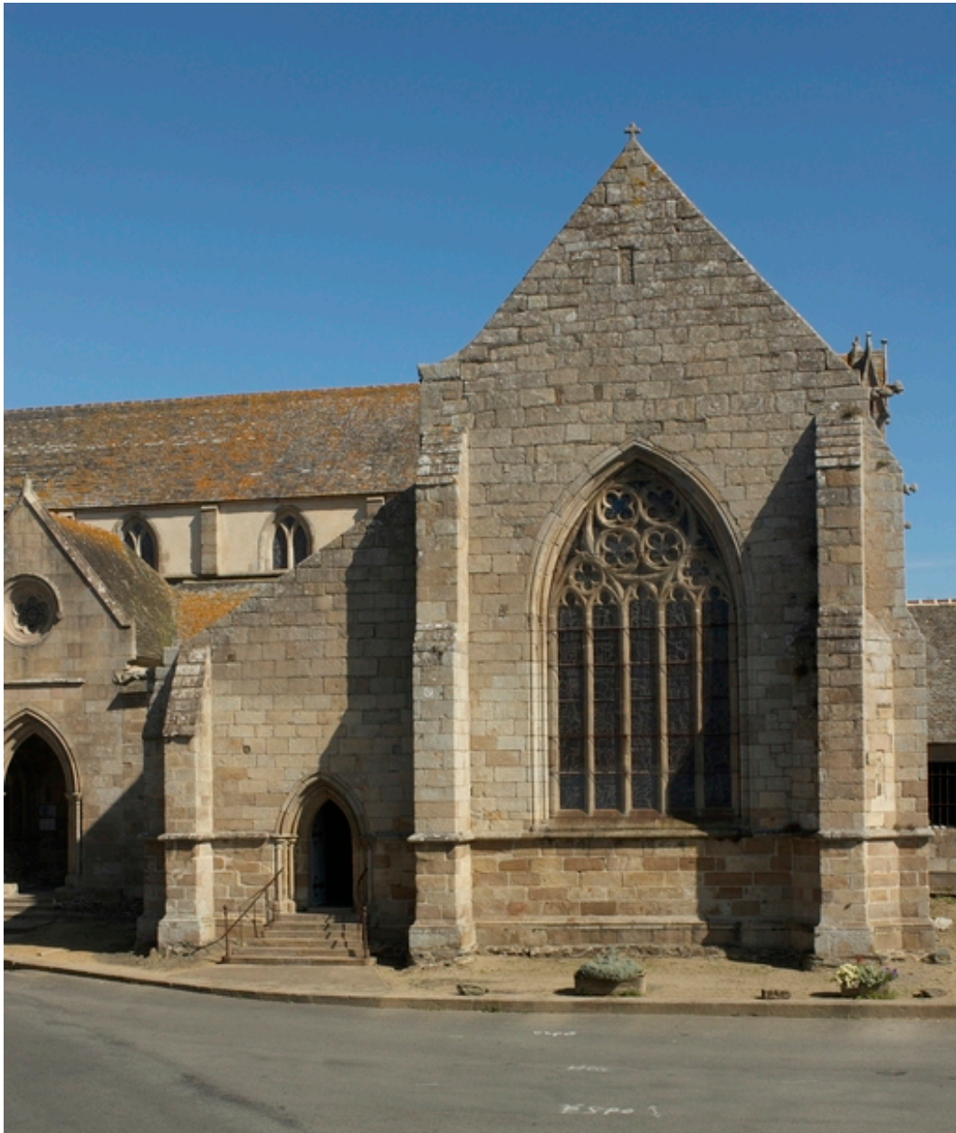
Chapelle et porche sud. Vue générale sud
