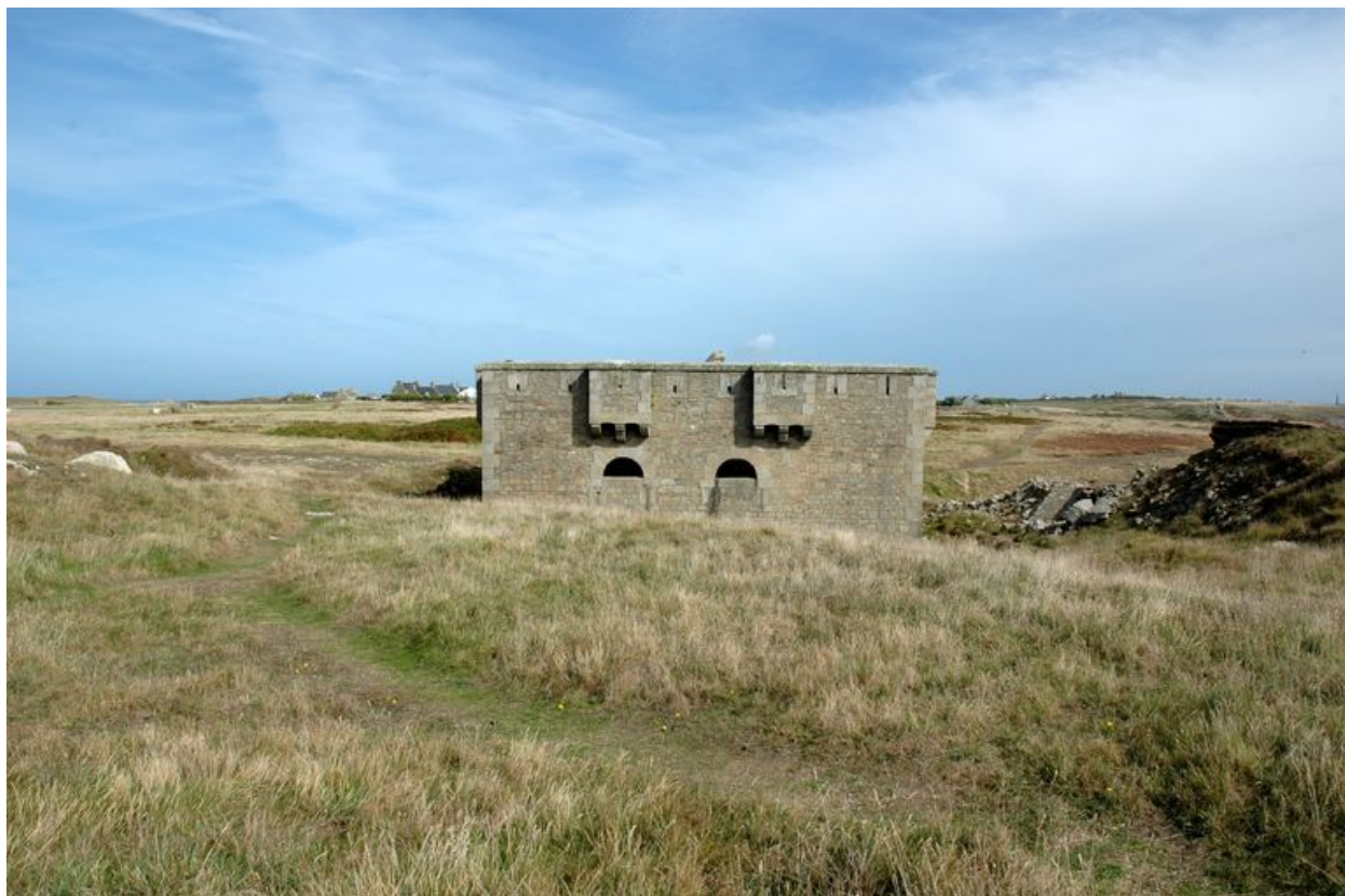
Vue du réduit de batterie de côte et de la batterie de Loqueltas, façade occidentale
