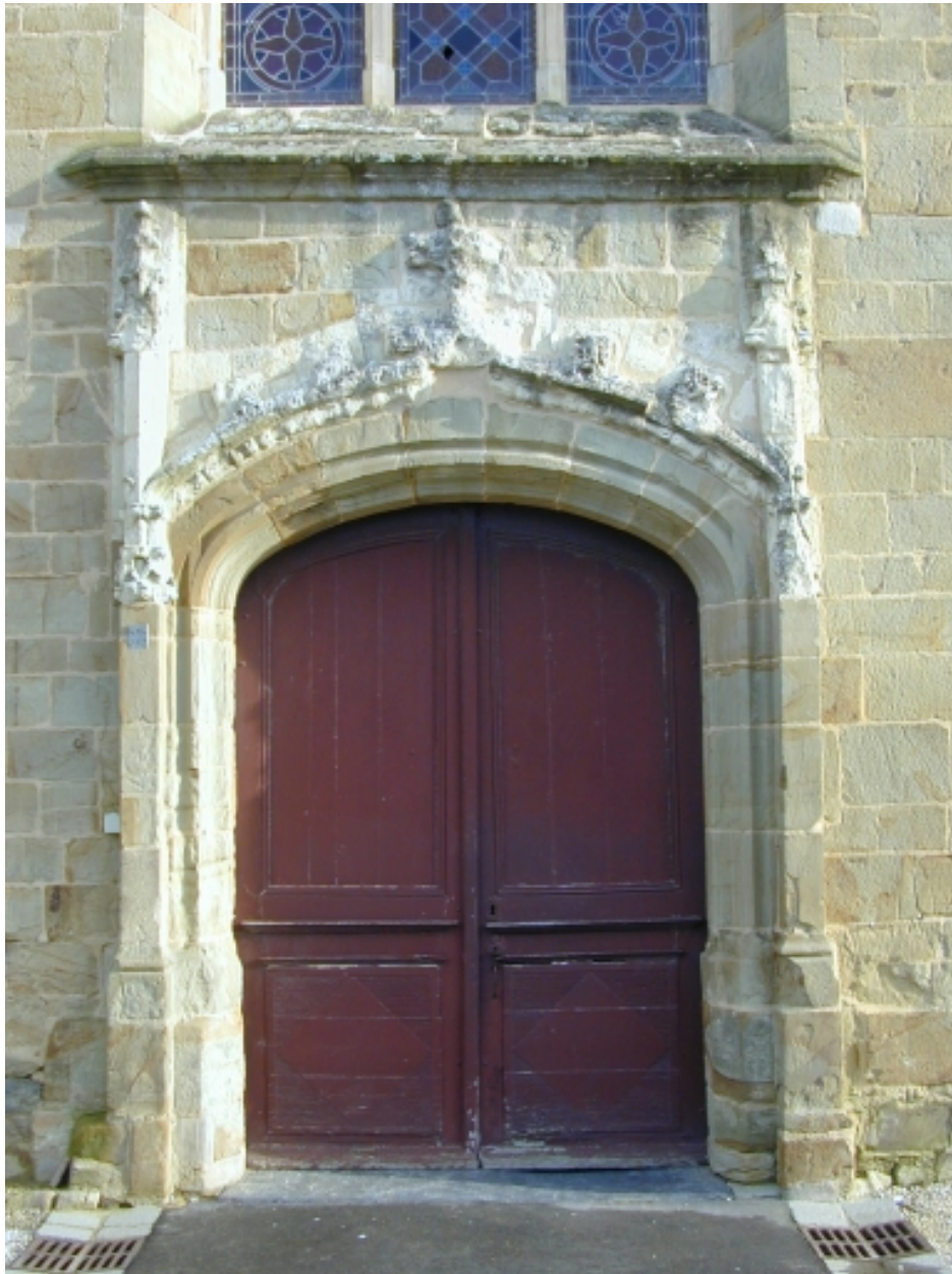
Le portail occidental : vue générale
