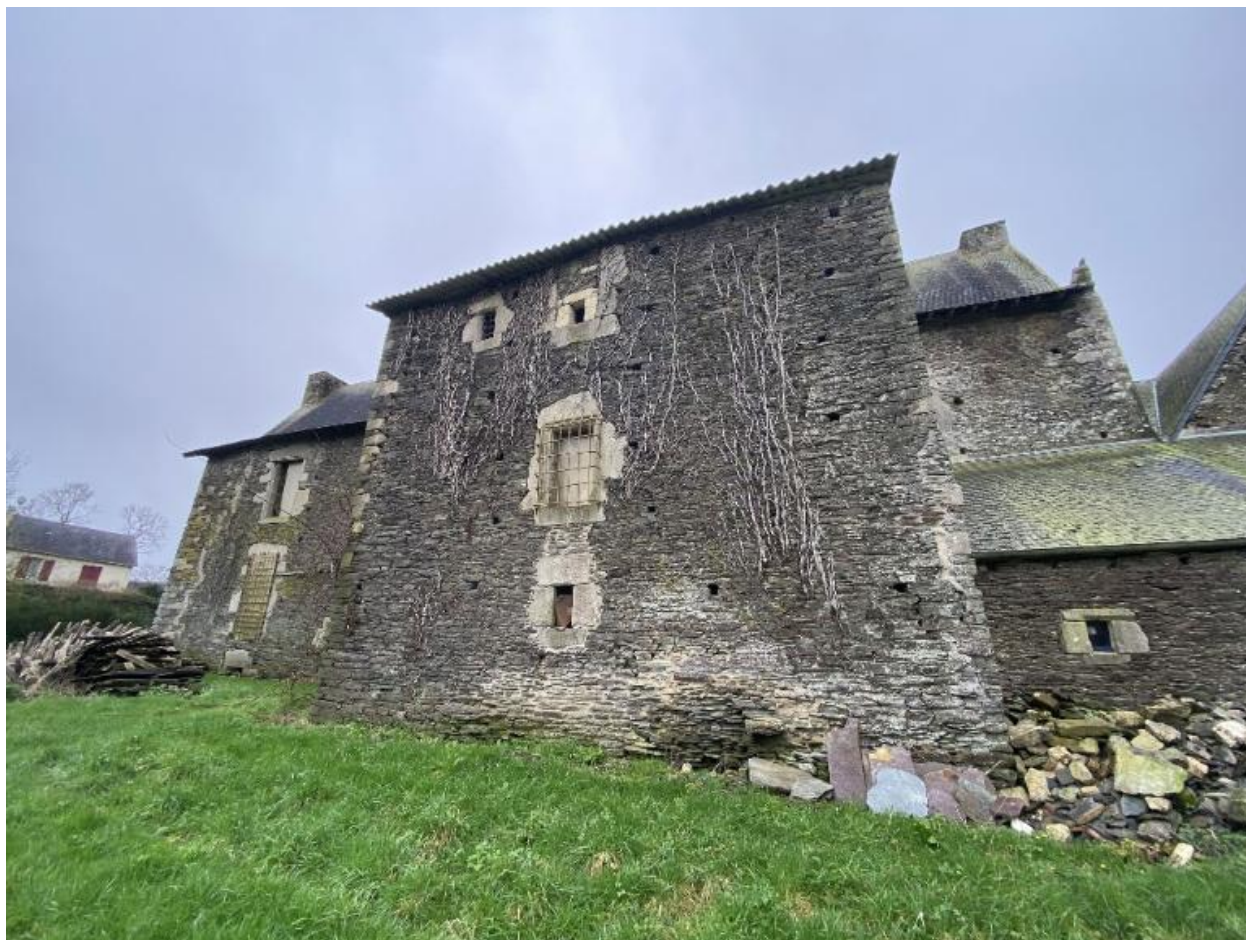
Élévation est, vue générale
