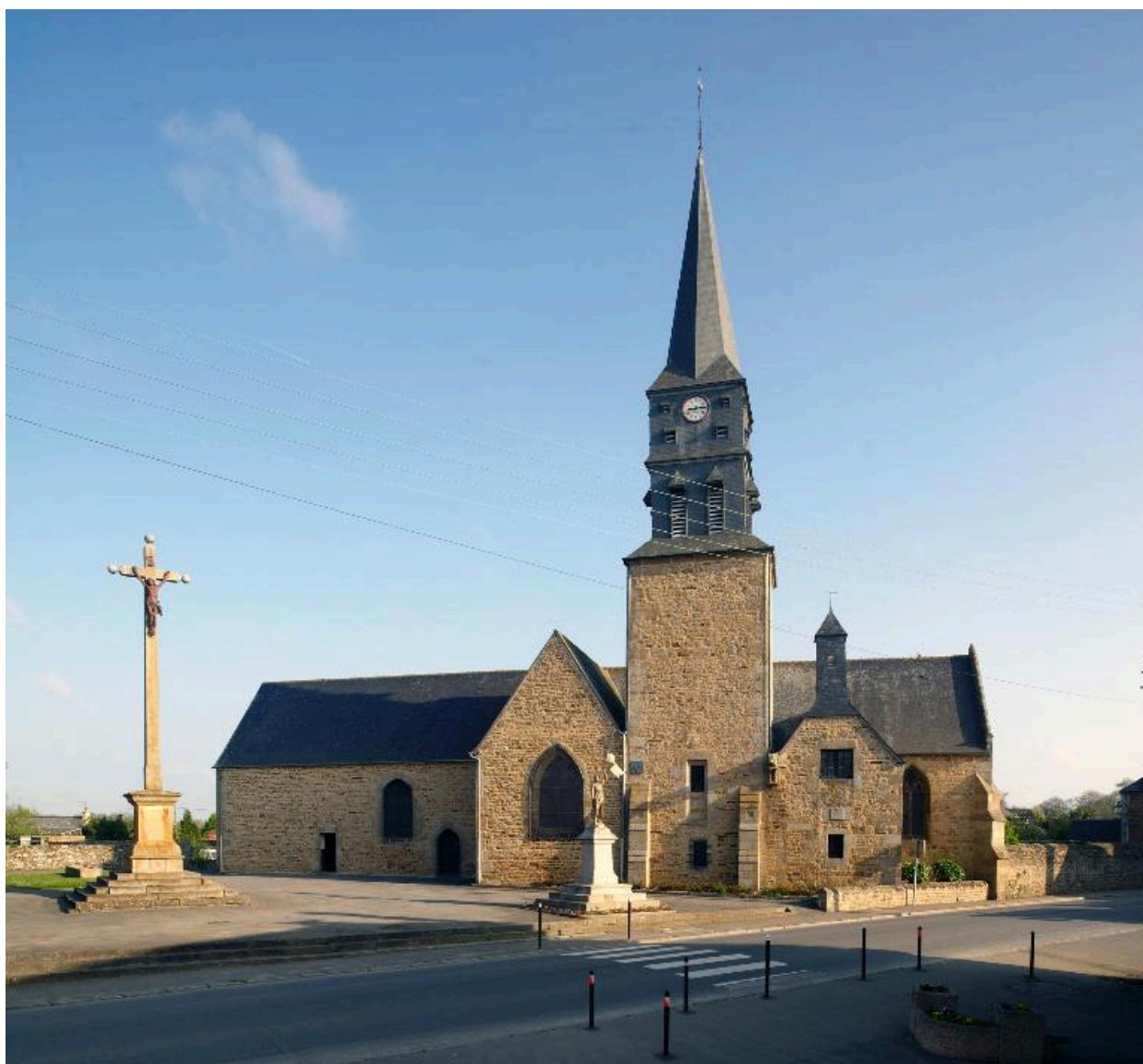
Vue générale : côté sud
