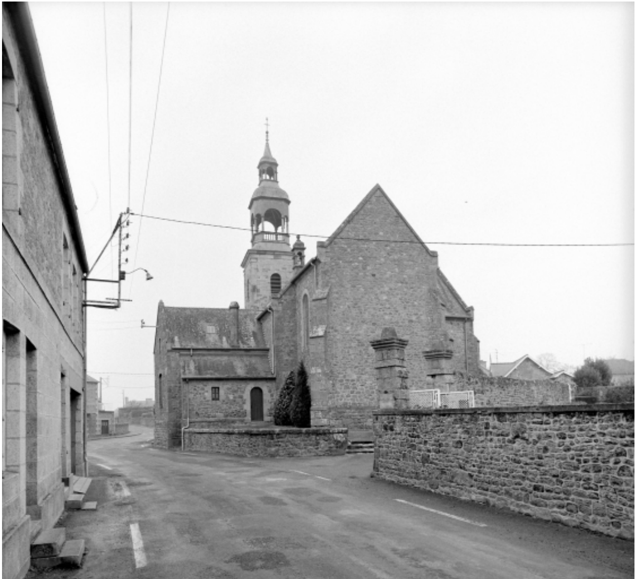
Elévation Nord : vue générale
