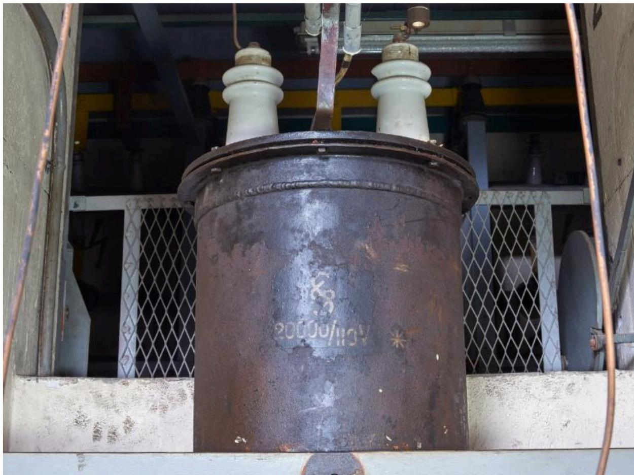
Vue de l'une des cellules hautes-tensions situées au deuxième étage : élément non identifié, inscription 20 000 /110V. La cuve est remplie d'huile non conductrice pour dissiper la chaleur
