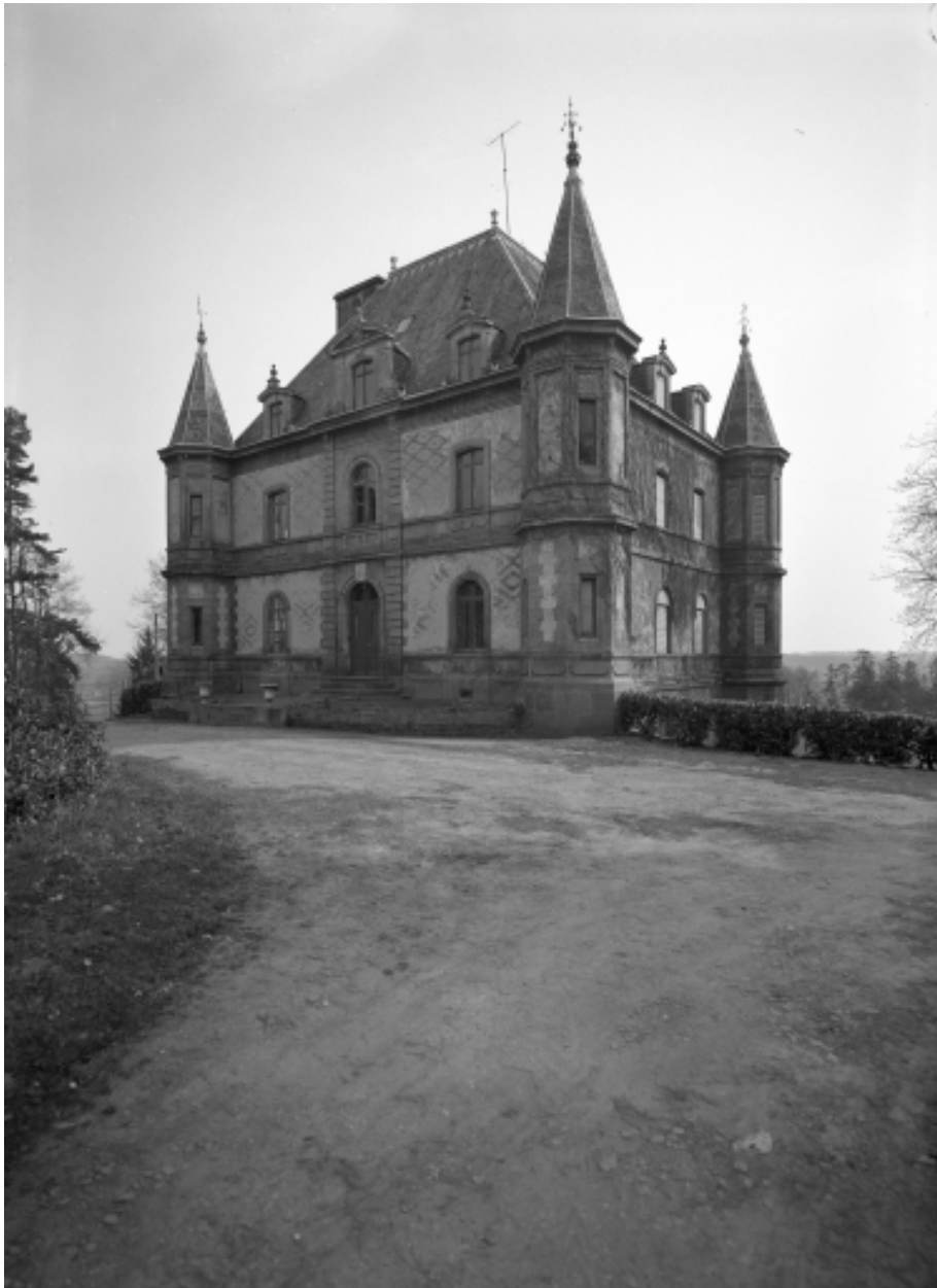
Façade nord, vue générale.
