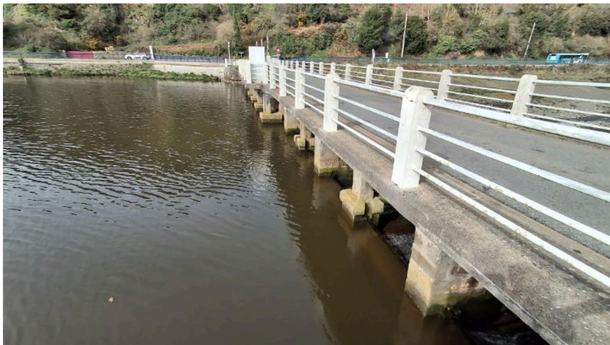
Vue de la jonction entre déversoir et tablier
