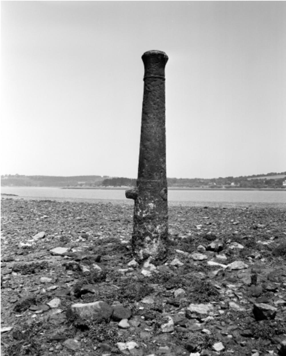
Vue de l'un des deux canons-bollards (pièces d'artillerie déclassées) plantés sur la grève : il permettait d'échouer les chalands à marée basse
