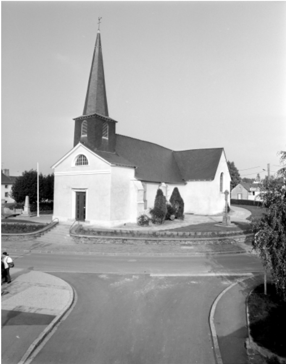
Elévation sud-ouest : vue générale
