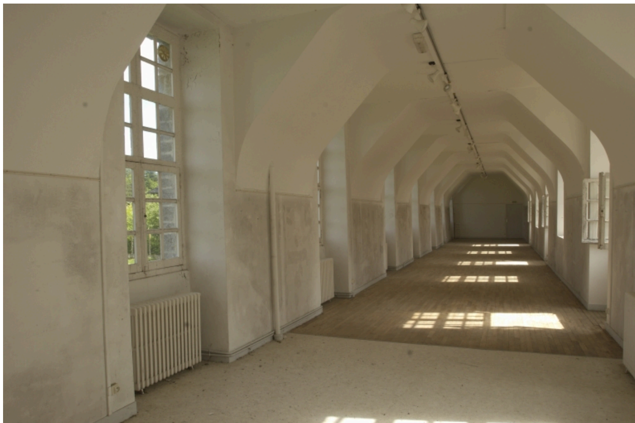
Aile est, étage de comble
