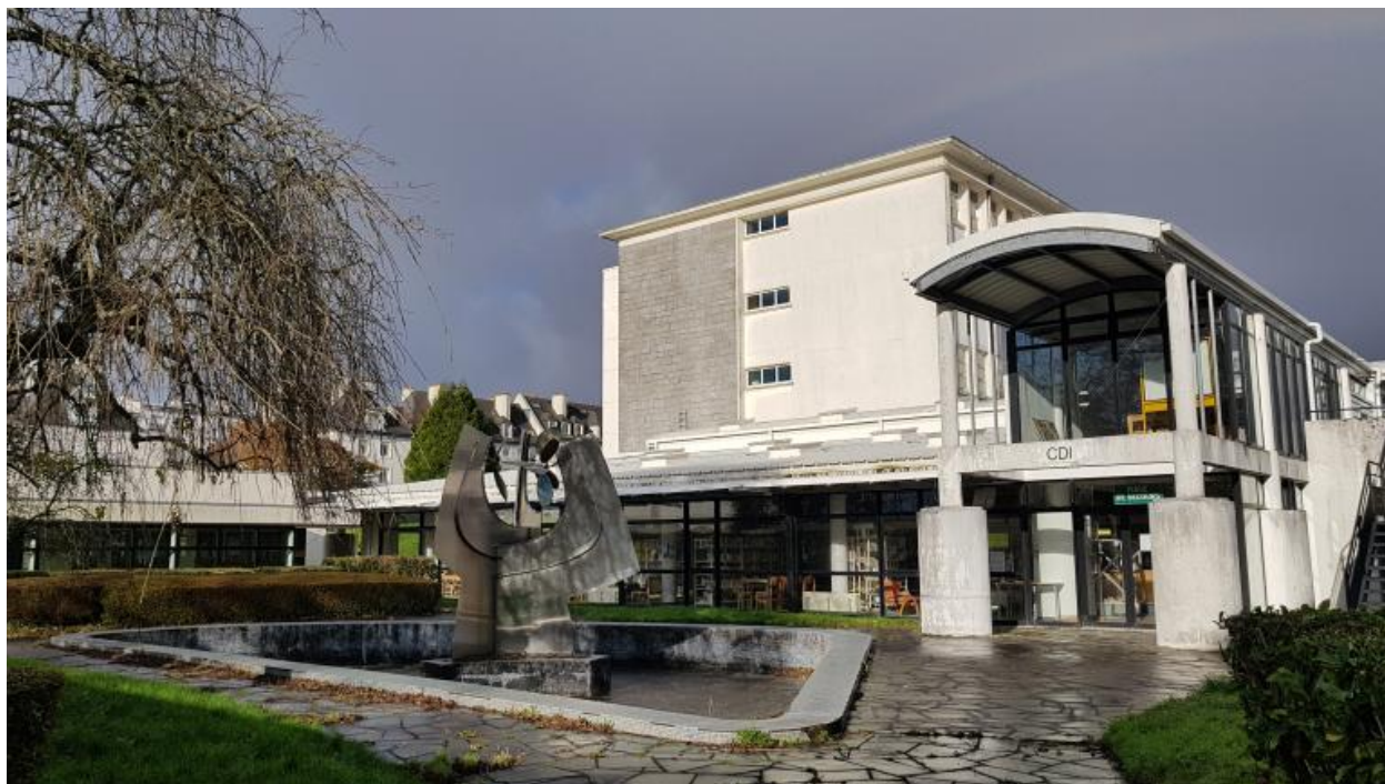
"Fontaine mobile", sculpture de Philippe Hiquily, 1973. Vue d'ensemble du patio en hiver, prise du sud-est.
