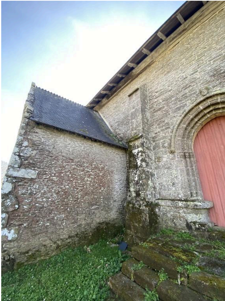
Élévation nord, détail
