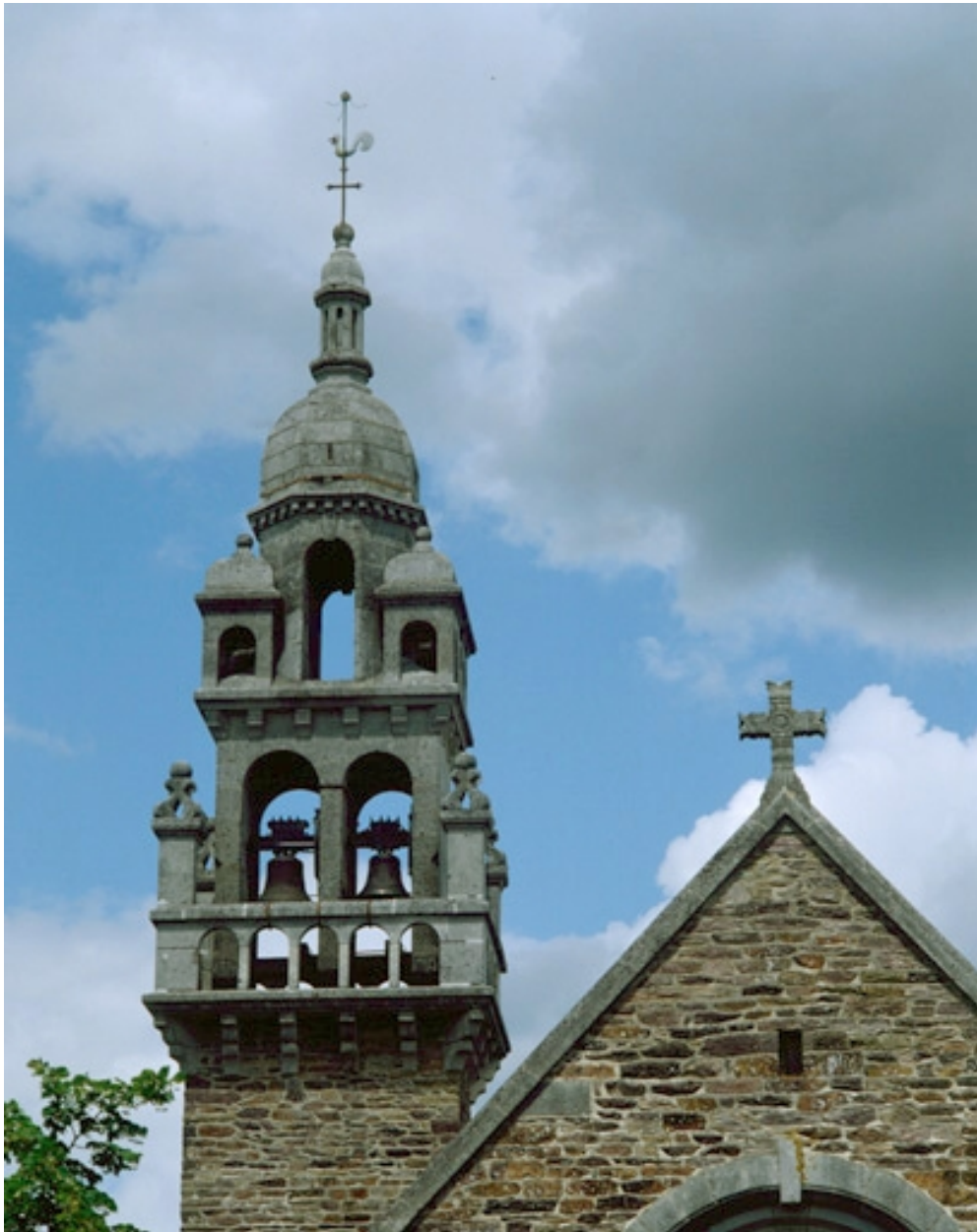
Élévation ouest, clocher, partie haute : vue générale
