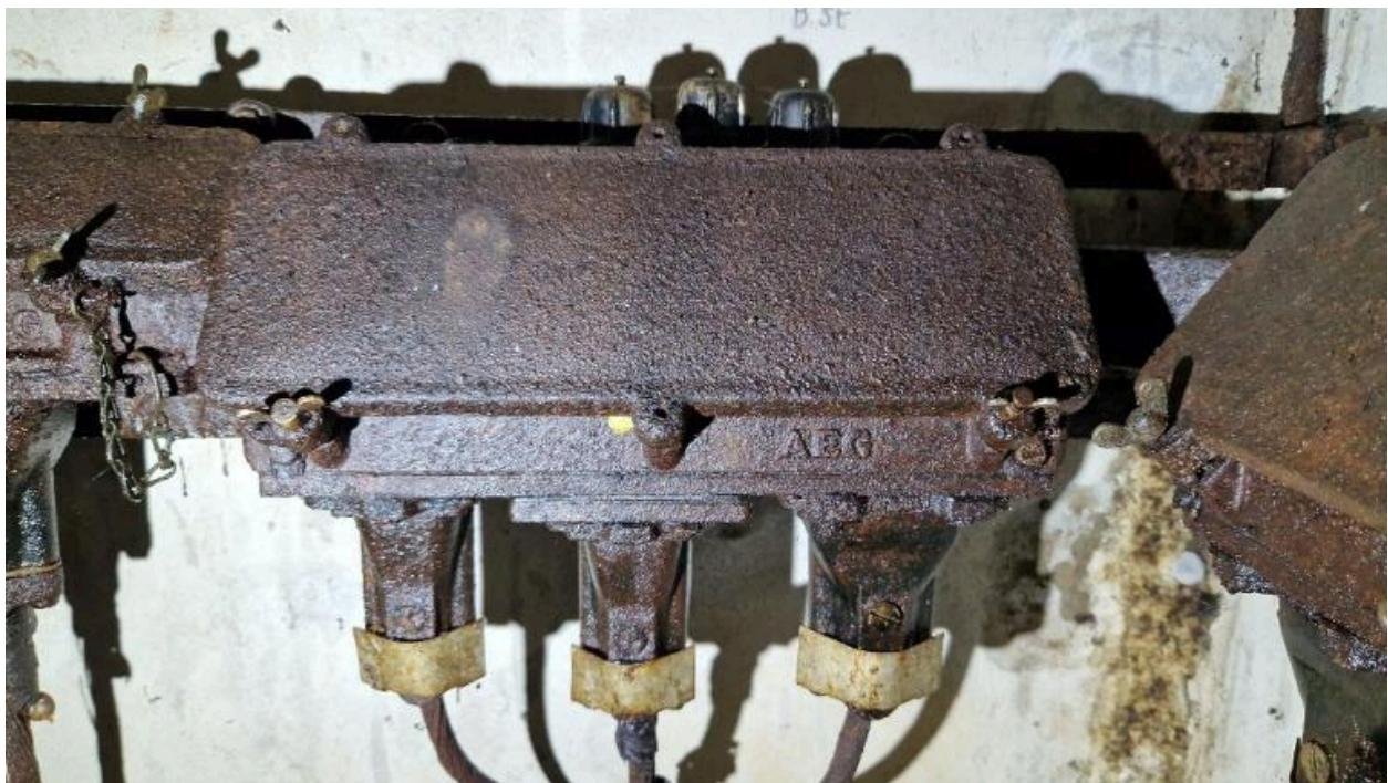
Vue intérieure : ensemble de plusieurs boîtiers de connexion (boîtier implanté contre le mur de gauche). Sur le mur peint en blanc : des instructions tracées au crayon gris pour connecter les câbles
