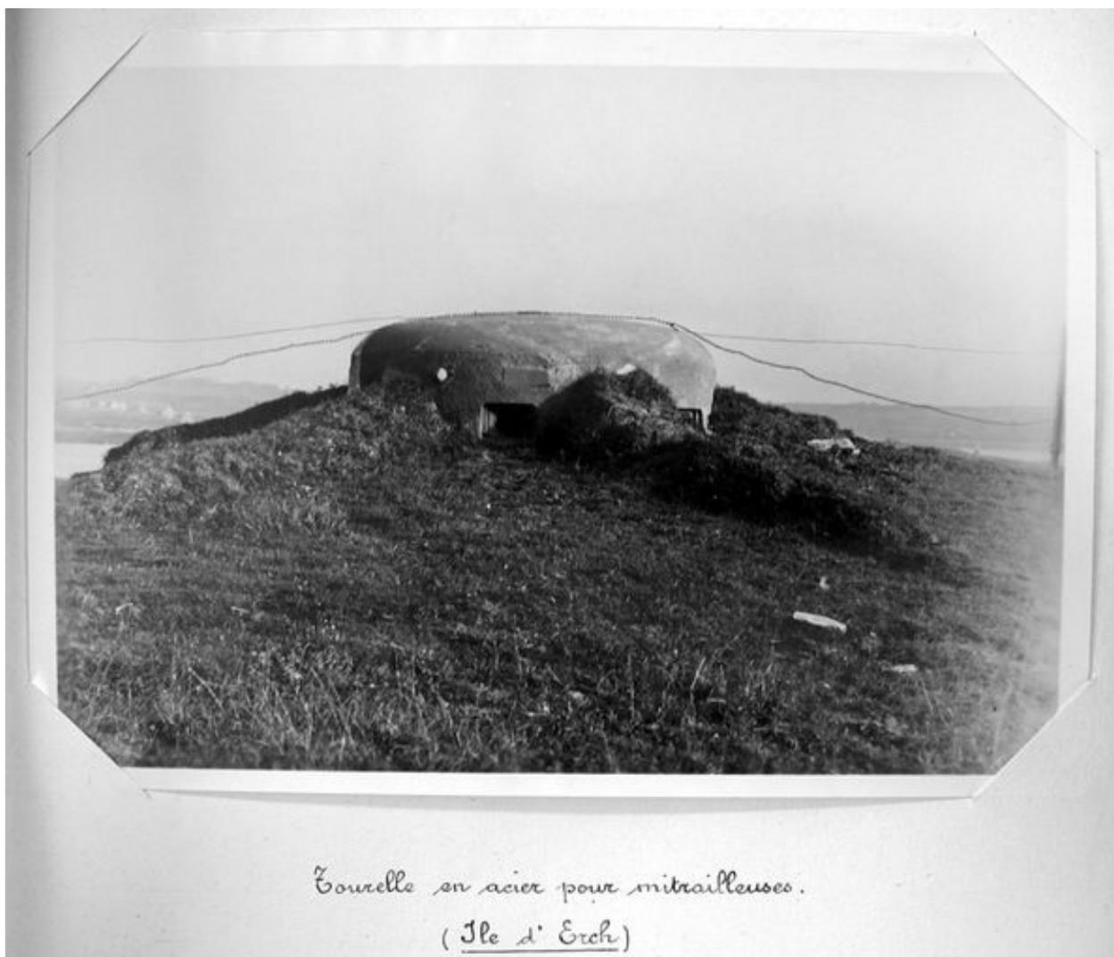
Vue de la cloche blindée pour mitrailleuse de l'ensemble fortifié de Énez Terc'h (photographie extraite du rapport Pinczon du Sel). Couronnant un bunker de type 634, elle a été ferrillée
