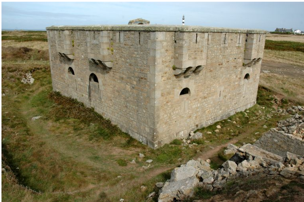
Vue du réduit de batterie de côte de Loqueltas, angle sud-ouest. En arrière-plan : le phare du Créac'h
