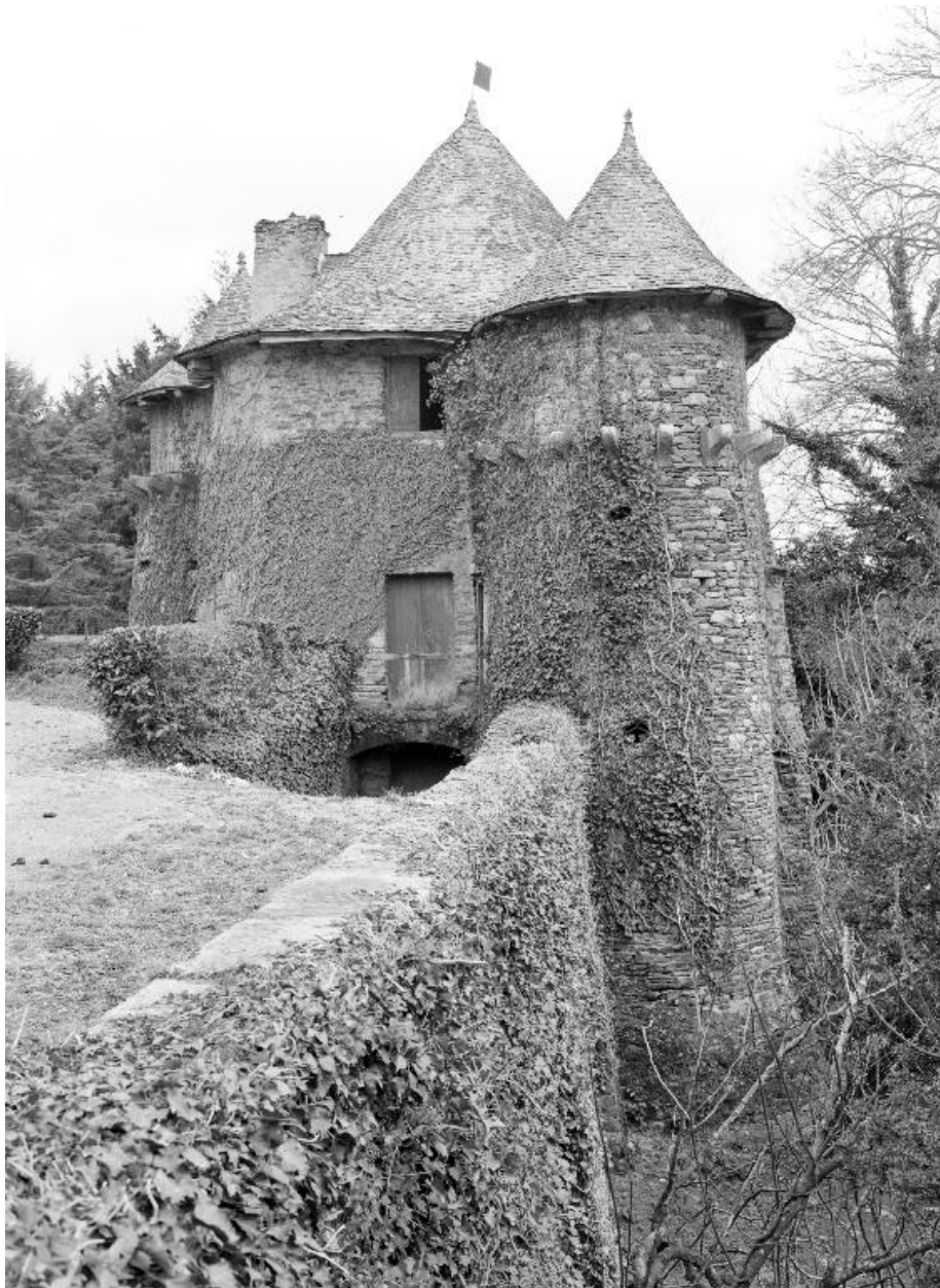
Château, tour sud-est, vue générale ouest.
