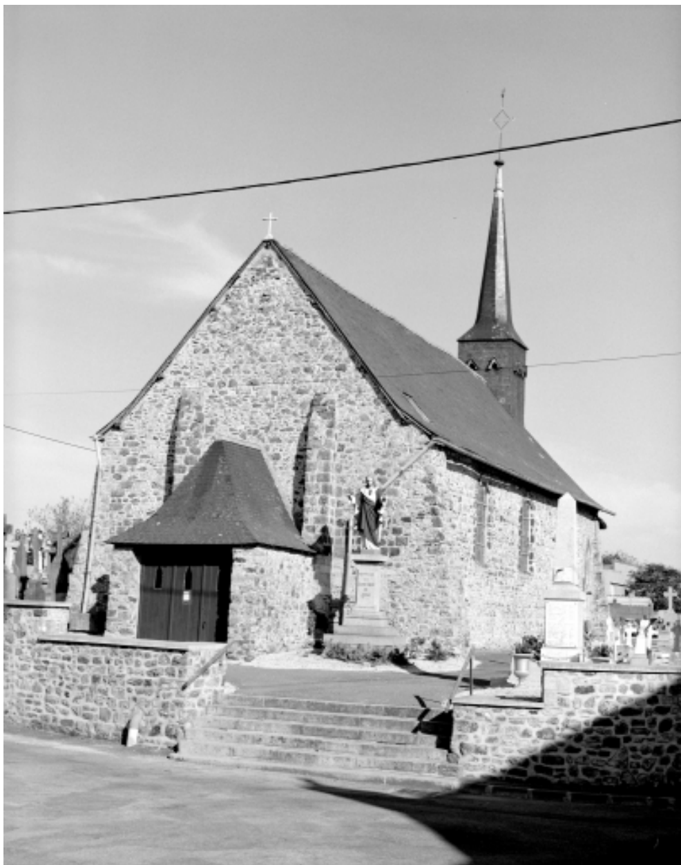
Elévation ouest, vue générale.
