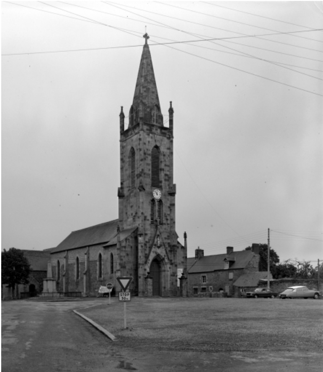
Elévation nord-ouest : vue générale
