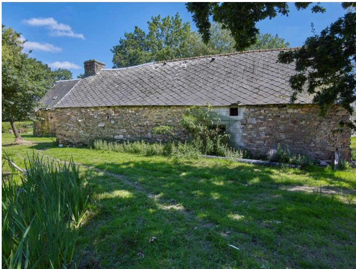
Alignement formé par le logis-étable 1753 et le logis unique. Elévation nord-ouest
