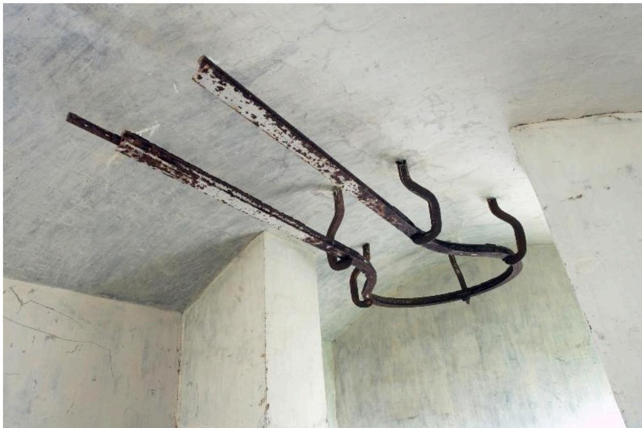
Vue intérieure du magasin à munitions (vers le fond) : fixations et rail pour la manutention des obus via un palan. Les murs, préalablement enduits sont blanchis à la chaux
