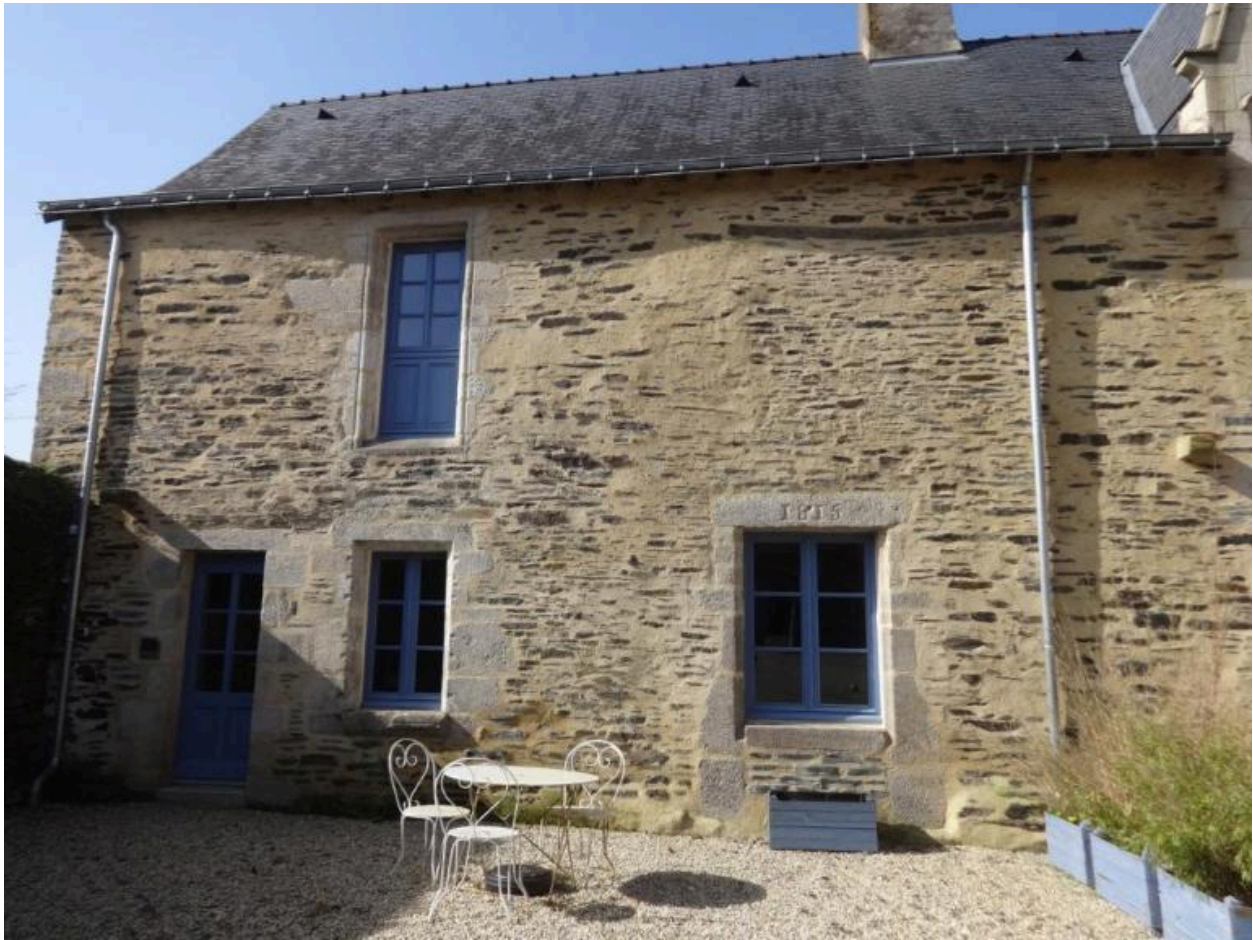
Ouvertures de la partie basse, élévation est, transformées au 20e siècle
