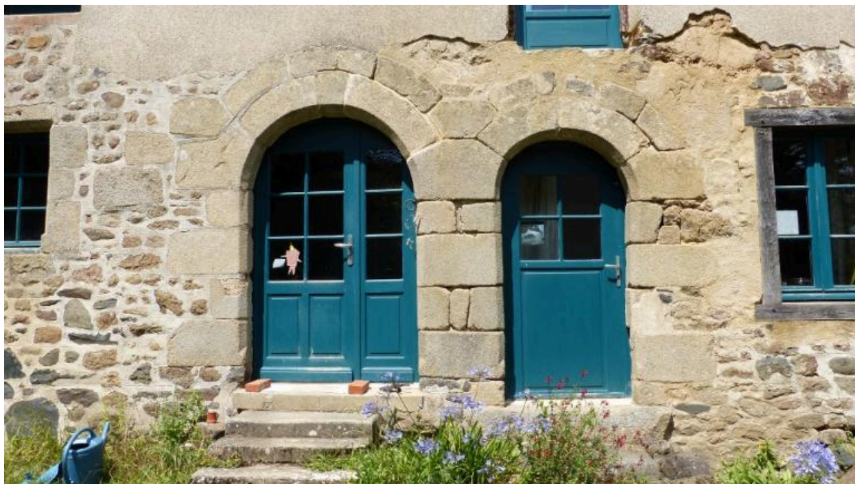
Détail des ouvertures, Montdidier (Hédé-Bazouges)
