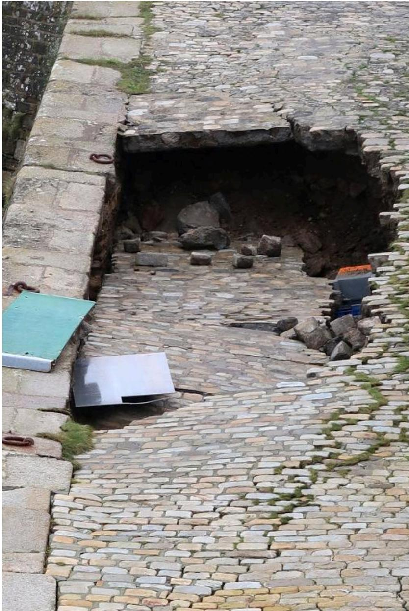
Cale Ouest du Drellac'h : vue rapprochée de l'effondrement (platelage) ; remblai de terre et de galets
