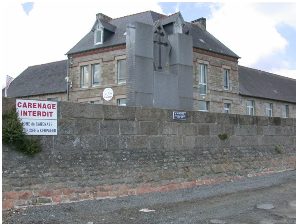
Vue des bâtiments situés devant l'ancienne digue rehaussée du Champ de Foire
